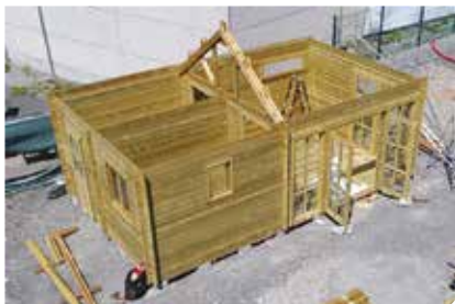
Modèle illustré en cours de montage avec 3 pièces et mezzanine.
